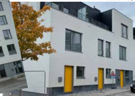
rue du Texas
